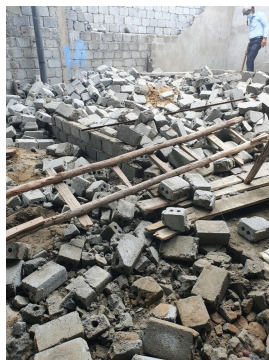
Lc lng chc nng x lý các trng hp ci ni sai qui nh
